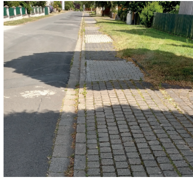
Gehwege und Müllcontainer Neuebersbach
